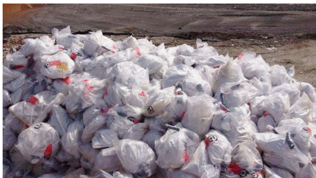
Des sacs de matériaux contenant de l'amiante prêts à être enfouis selon les règles de l'art. HSE CONSEILS
